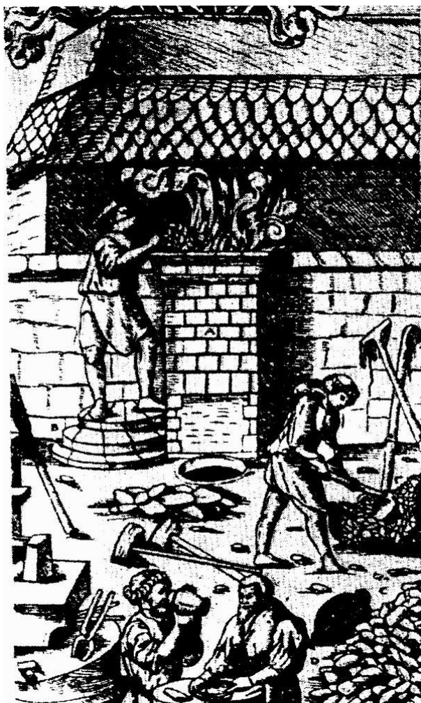
Rys. 1.9. Dymarka wysoka (szybowa) z połowy XVI wieku stosowana w hutnictwie niemieckim, rosyjskim i włoskim. Umożliwiała produkcję żelaza albo surówki. Dymarka Hieronima Cacci służyła do produkcji surówki
