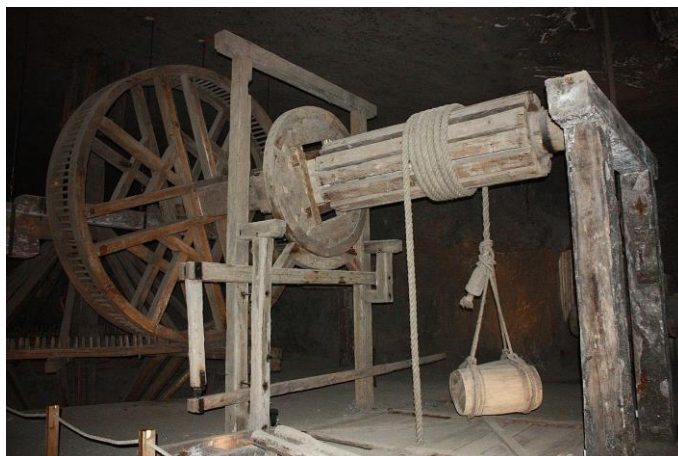
Fot. 3.8. Kierat polski w kopalni soli w Wieliczce (największy i najstarszy kierat w muzeum, jedyny zachowany kierat tego typu), źródło Wikipedia. Kierat wyposażony w poziomy wał służy do pionowego transportu ciężarów. Początkowo były one montowane nad szybami kopalń, a od XVII wieku wewnątrz kopalń w Wieliczce i Bochni. Były napędzane przez cztery pary koni i mogły wyciągać do 2 ton urobku z głębokości 80 m. Do blokowania służył hamulec jednoszczękowy
