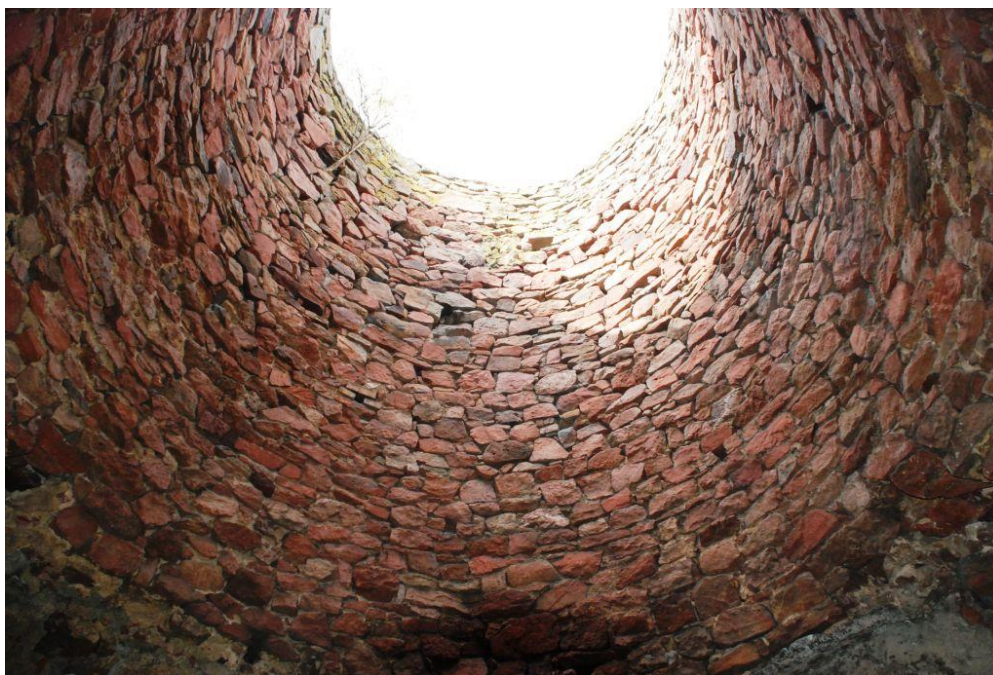
Fot. 1.7. Wnętrze wielkiego pieca w Kuźniakach, źródło: Internet
